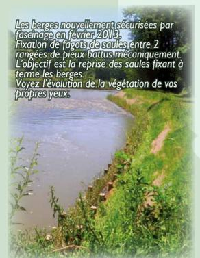
Les berges nouvellement sécurisées par fascinage en février 2013. Fixation de fagots de saules entre 2 rangées de pieux battus mécaniquement. L'objectif est la reprise des saules fixant à terme les berges. Voyez l'évolution de la végétation de vos propres yeux.
